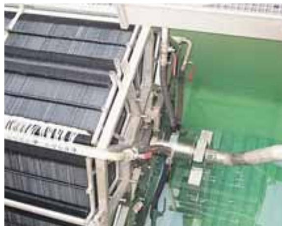
EDAR con una unidad VRM® 20/252 para 900 hab. eq. en Knautnaundorf (Alemania)
