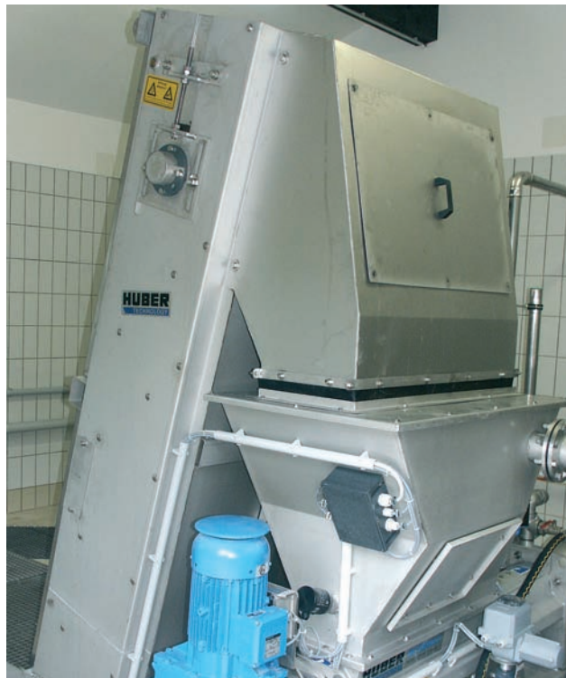
Vista trasera de un tamiz RakeMax® que descarga en una prensa WAP/SL
