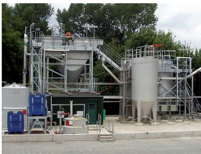
Decantador SuperSettler y filtro SuperSand: una completa gama de productos para aguas y efluentes, de Nordic Water
