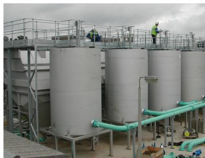
Instalación de decantadores SuperSettler y seis tanques de floculación de 19 m³ en Reino Unido
