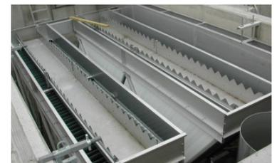
El agua clarificada se recoge en los vertederos con muescas en V y se transporta al canal de salida
