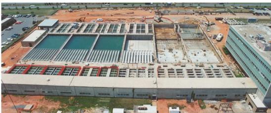
Ampliación con paquetes de lamellas SuperSettler y rascadores de lodos Zickert de una instalación en Franklin, Estados Unidos.
