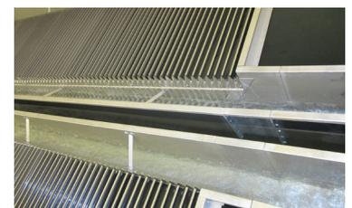
Paquetes SuperSettler en un tanque de hormigón con rascador de lodos de fondos Zickert
