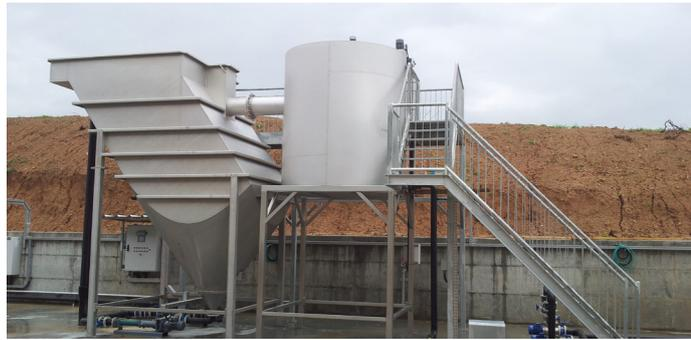
SuperSettler LS es un decantador de lamellas con una tolva de concentración de lodos en su parte inferior
