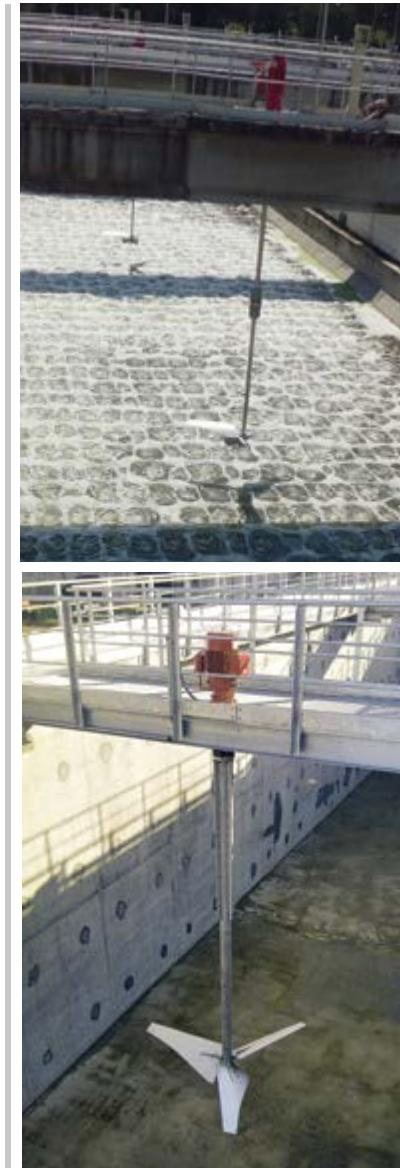
**Agitadores de montaje vertical****Largo eje máx:** 6000 mm**Diametro rolete máx:** 3500 mm**Potencia:** 0,18 ÷ 45 kW
