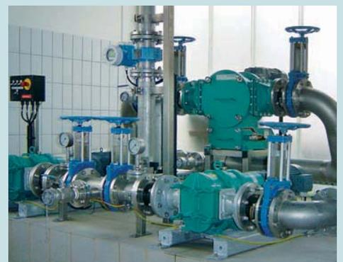
Multichopper para maceración y acondicionamiento en combinación con una bomba rotativa lobular para la alimentación de una separadora centrífuga.
