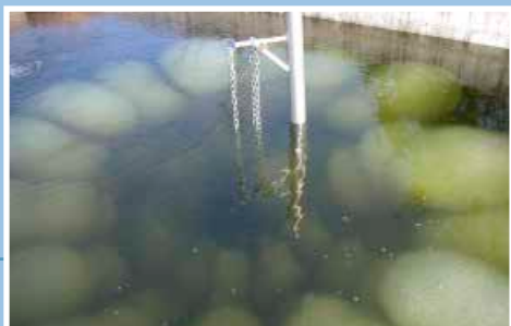
Fasi di avviamento di aeratore sommerso radiale. Starting stages of a radial submersible aerator.
