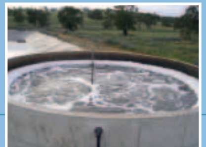
Aérateur submersible SCL posé sur le fond d'un bassin. Instalación de aireador sumergido modelo SCL.
