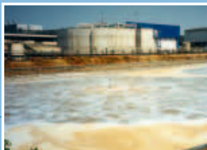
Aérateurs immergés SCL dans une station d'épuration industrielle. Aireadores sumergidos modelo SCL instalados en instalación de depuración.
