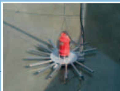
Aérateur submersible SCL posé sur le fond d'un bassin. Instalación de aireador sumergido modelo SCL.
