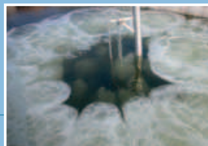
Phases 1, 2 et 3 de démarrage d'un aérateur immergé. Fases de arranque de aireador sumergido radial.
