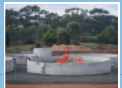
Aérateur de surface flottant type ASP-V. Instalación de aireador de superficie modelo ASP-V, versión flotante.
